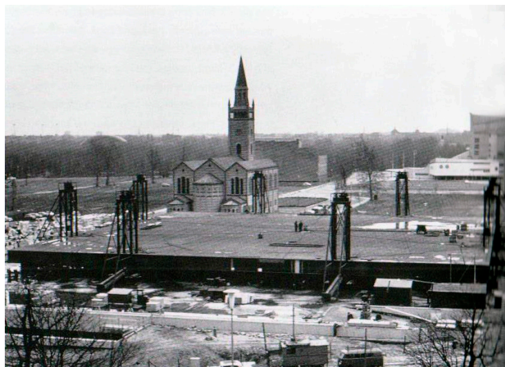
Abb. 3: Mies van der Rohe, Neue Nationalgalerie sowie nördlich dazu die Matthäuskirche, 1962–67, Berlin.
