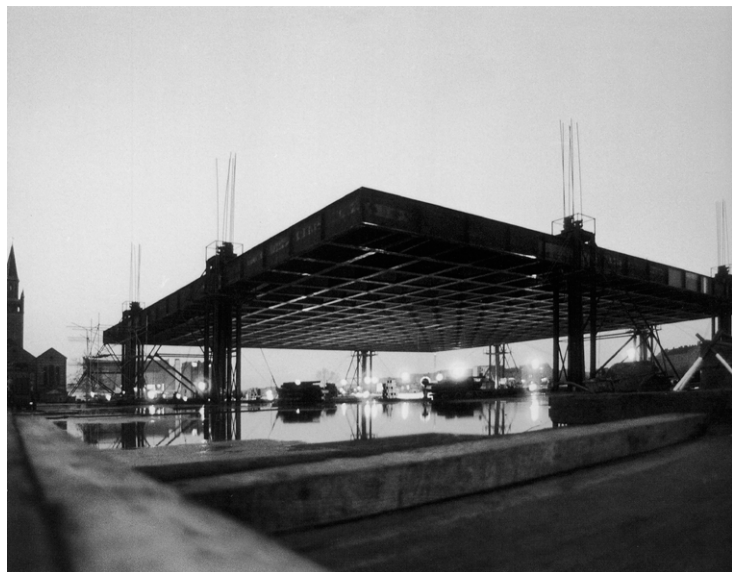
Abb. 4: Mies van der Rohe, Neue Nationalgalerie, Nahezu vollkommen angehobener Trägerrost des Stahldaches der Neuen Nationalgalerie am 05. April 1967, 1962–67, Berlin.
